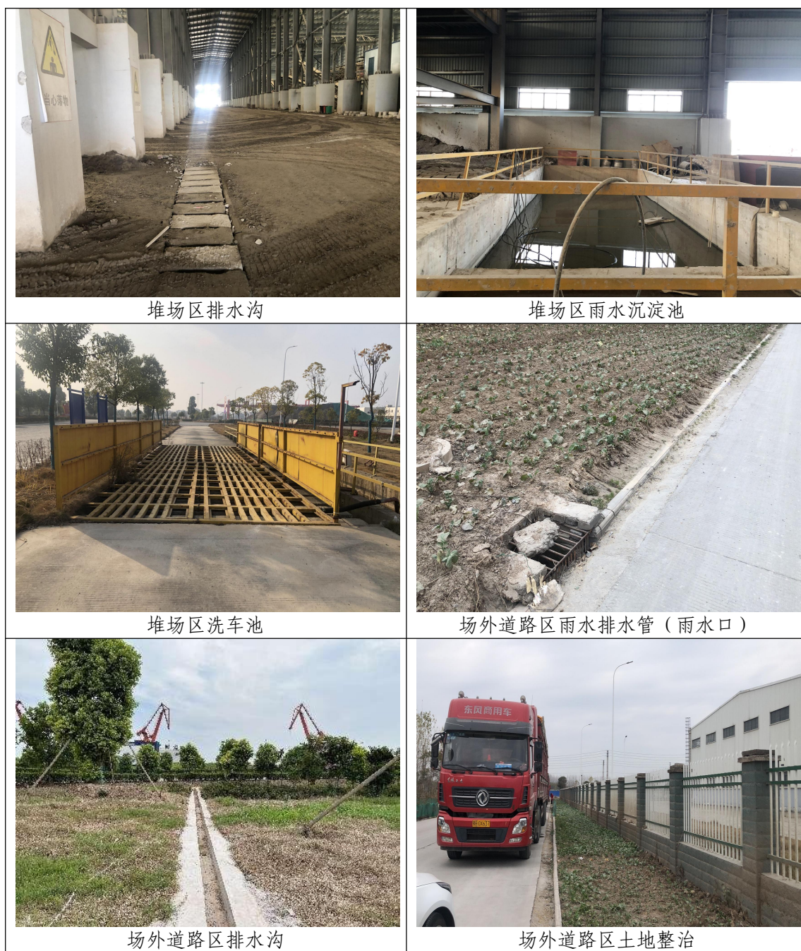
图 4.1-1 水土保持工程措施
