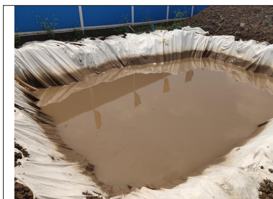
码头区泥浆池
