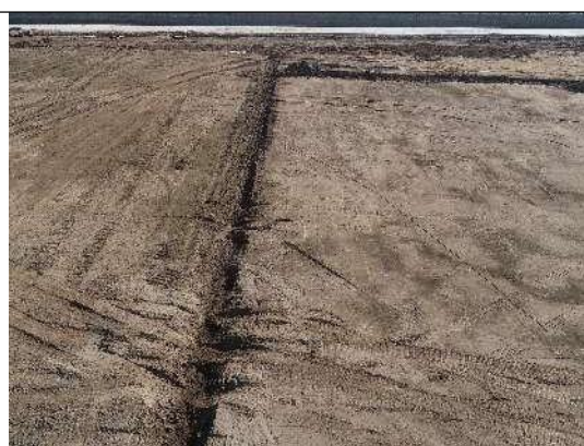
堆场区临时排水沟
