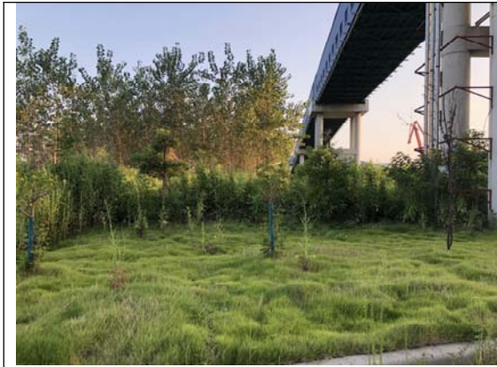
2号施工便道现状
