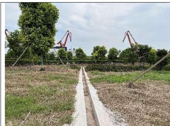
Y字下堤道路西侧排水沟
