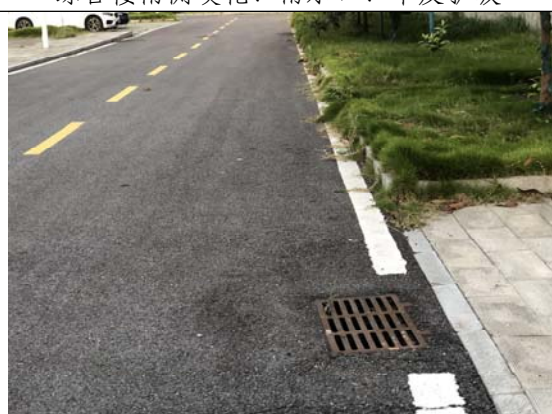
宿舍楼东侧道路及雨水口
