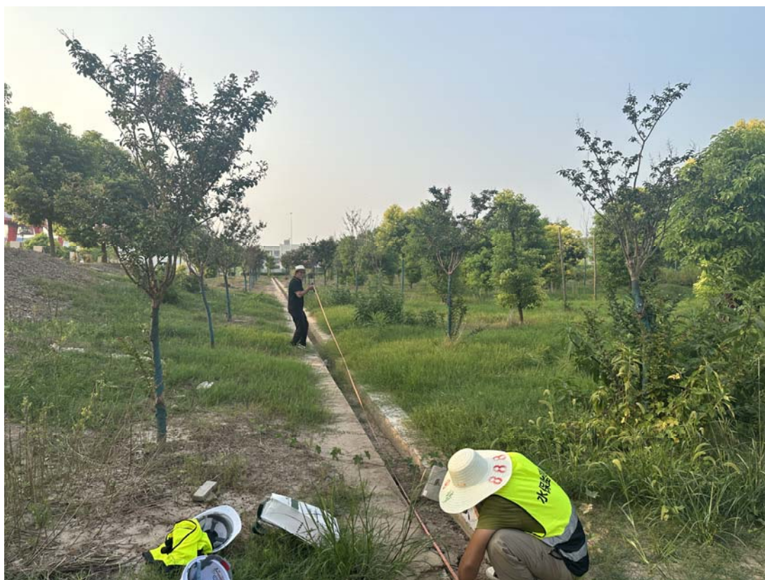
水土保持工程措施监测
