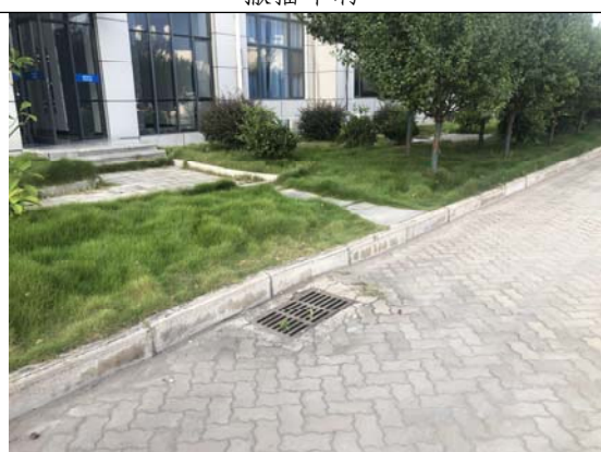
综合楼南侧硬化、雨水口、草皮护坡
