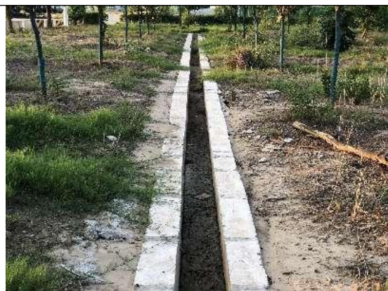
沿1号引桥下堤道路排水沟
