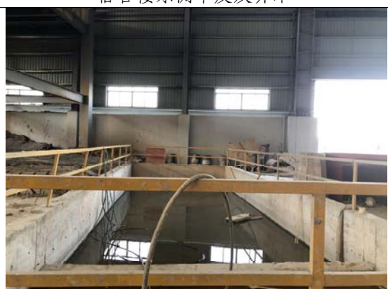
散货堆场雨水沉淀池
