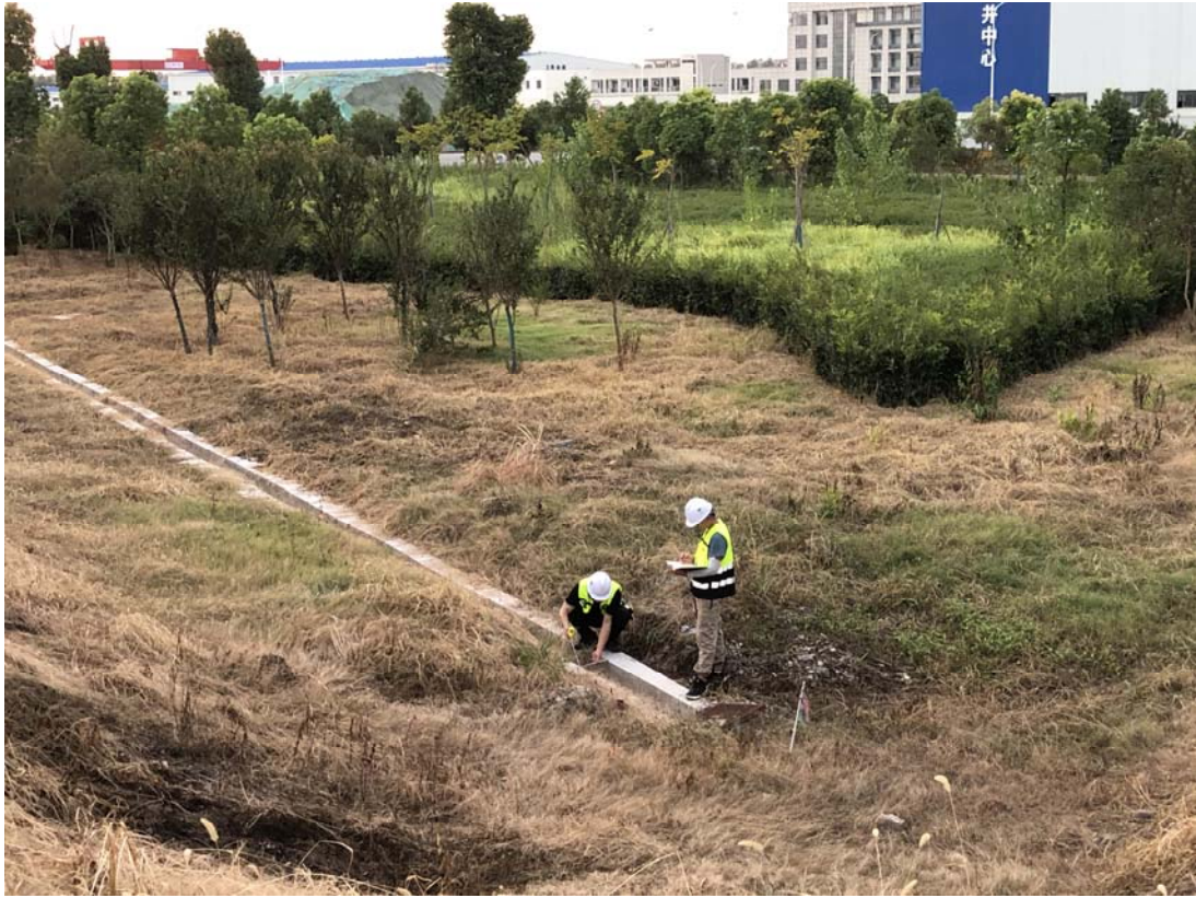
水土保持工程措施监测
