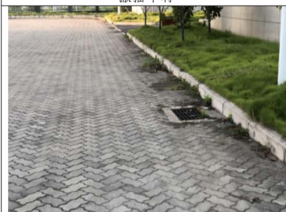
件杂仓库区硬化、雨水口、草皮护坡
