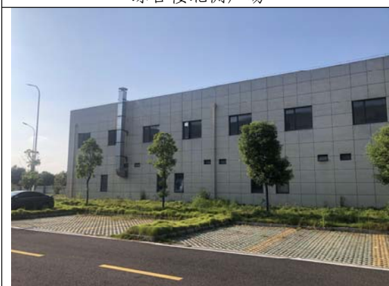
综合楼北侧广场透水砖
