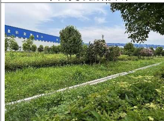
Y字下堤道路东侧排水沟
